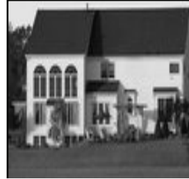
Fig.1.3(b) The actual Construct
